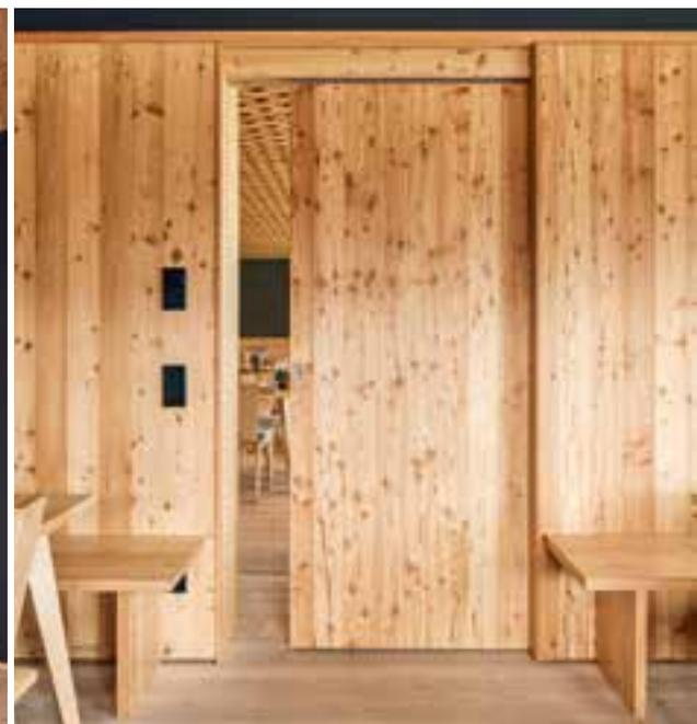
Dunkle Wände setzen die Massivholz-Rahmentüren aus Holz – hier eine gegenläufige Tür – in Szene. Die Schiebetür passt sich in die Wandoberfläche ein.
