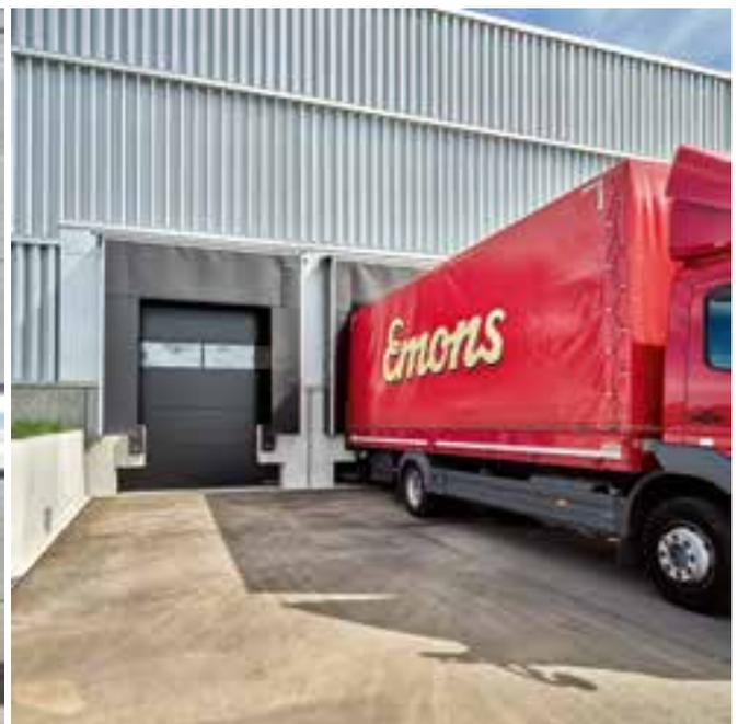
Die Ladebrücke wird zentimetergenau für die Verladung ausgefahren. Die Planentorabdichtungen schützen vor Witterungseinflüssen.
