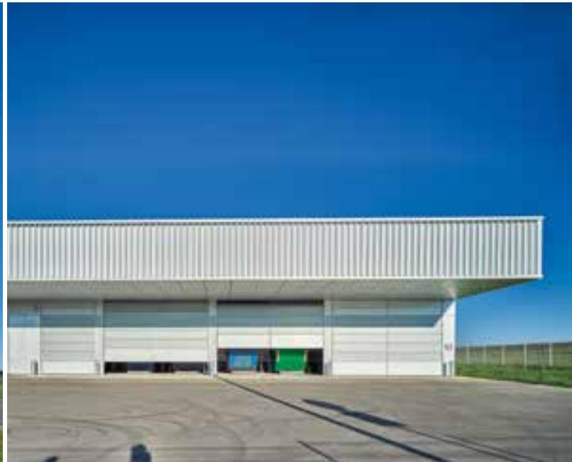
Die bauseitig beplankten Industrie-Sektionaltore passen sich optimal in die Fassadengestaltung ein.
