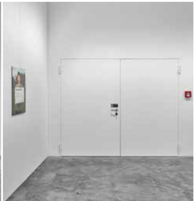
Hochwertige Türansicht im Detail: Die zweiflügeligen Hörmann Objektüren aus Stahl haben einen flächenbündigen Übergang der Türflügel.
