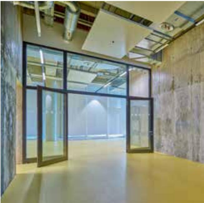
2-flügelige Rohrrahmen-tür mit zwei feststehenden Seitenteilen.
