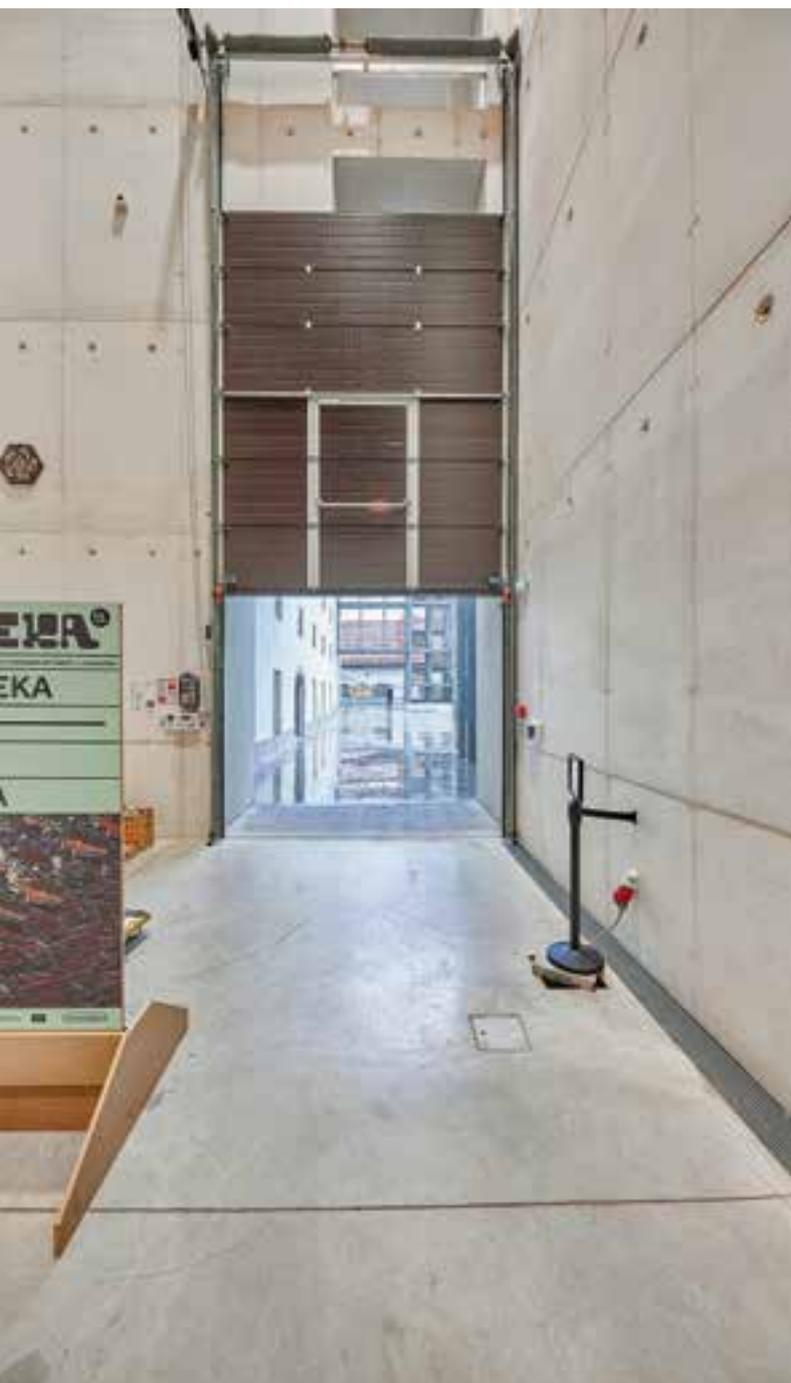
Sichtbare Technik: das Industrie-Sektionaltor mit Vertikalbeslag.
