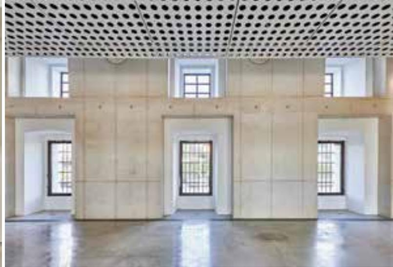
Innen ist der bestehenden Fassade eine Stahlbetonwand vorgesetzt.
