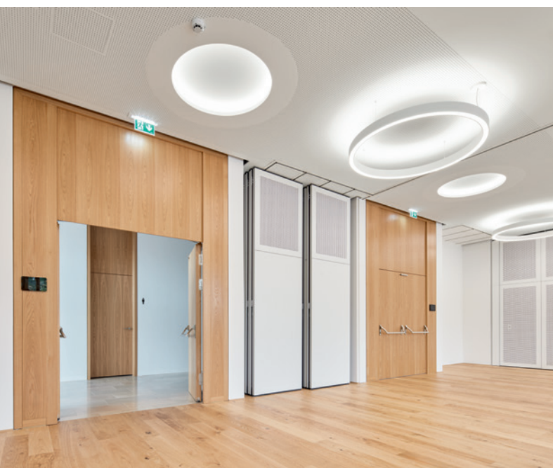
Die zweiflügeligen Türen im Konferenzraum sind mit Panikdrückern ausgeführt.
