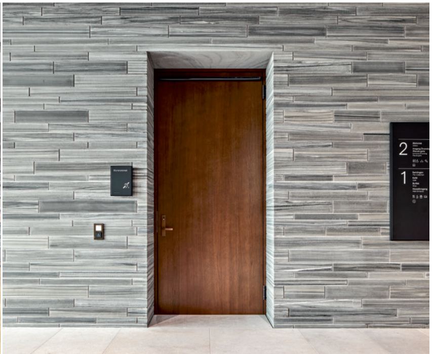
Die Maserung der gebeizten Türblätter aus Eiche ähnelt der des Steins – ist aber senkrecht ausgerichtet.
