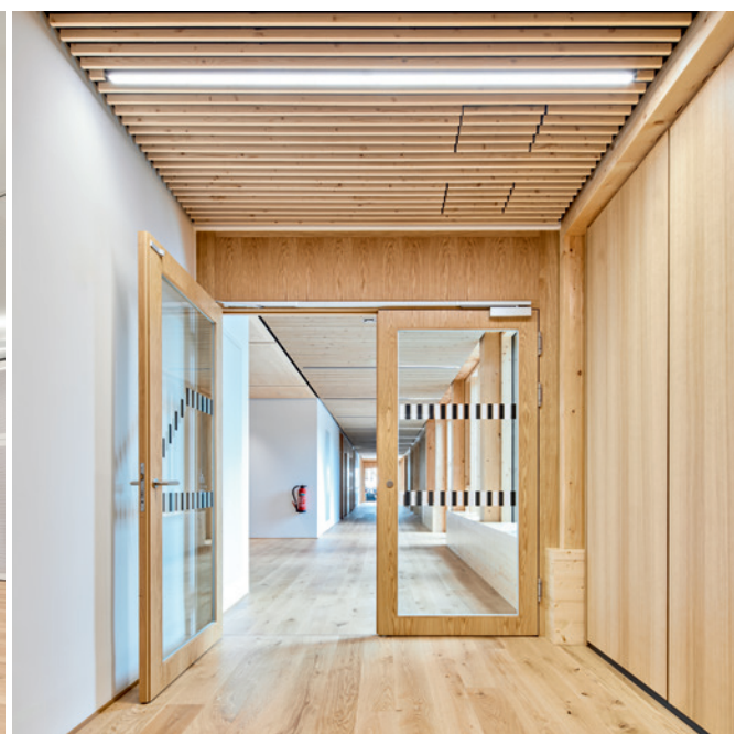
Die verglasten Türen sind mit Folien als Kollisionsschutz versehen.
